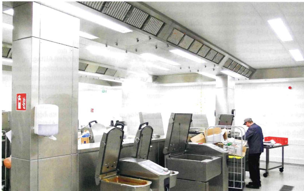
Der Lüftungshauben- und Lüftungsdeckenhersteller Rentschler Reven setzt bei seinen Systemen neben dem Absaugen zusätzliche Impulse wie beispielsweise einen Stützstrahl ein, der die aufsteigende Abluft anzieht.
